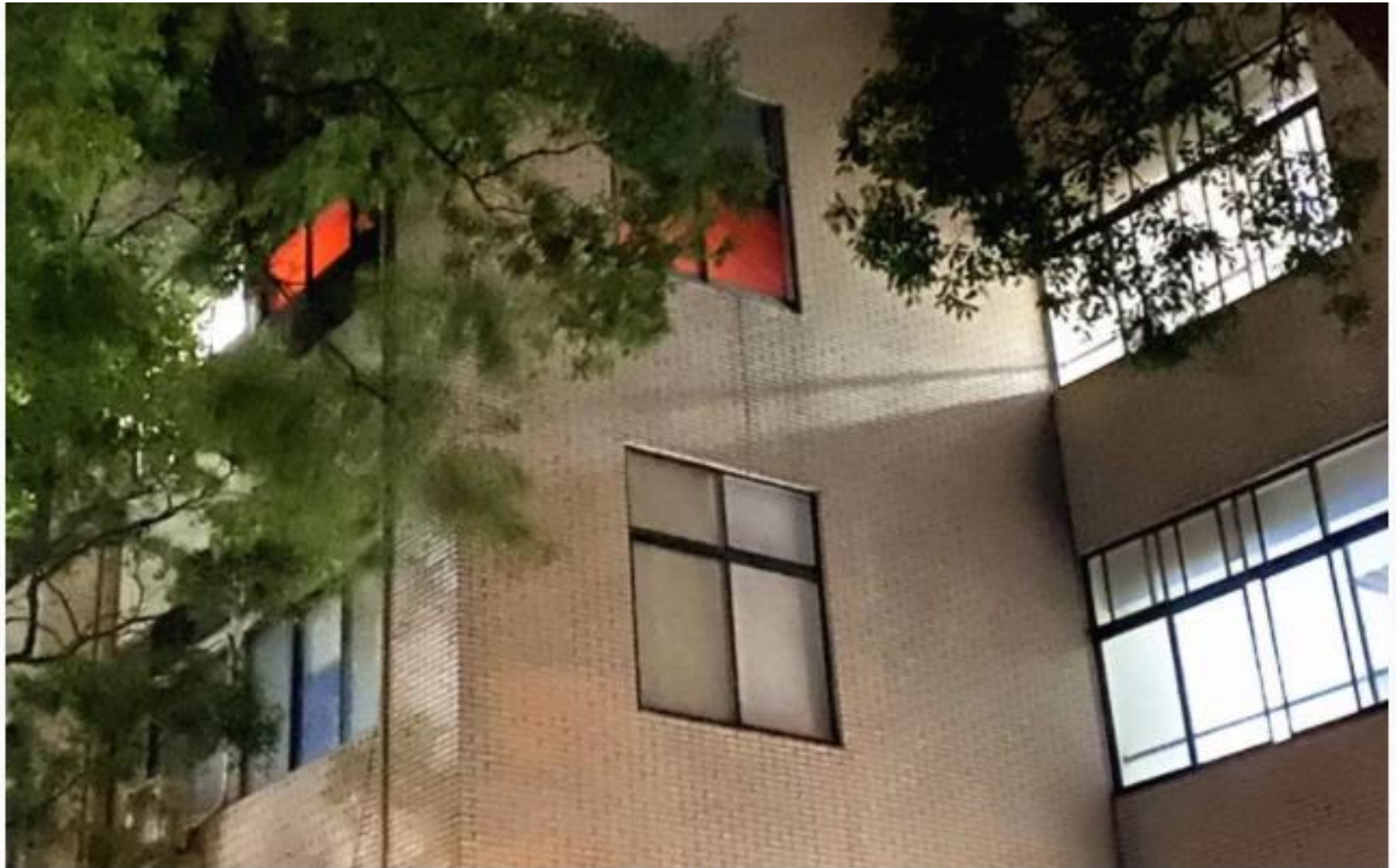
國立陽明交通大學18日凌晨12點多發生火警，起火地點在工學院工程五館3樓辦公室。圖／民眾提供
